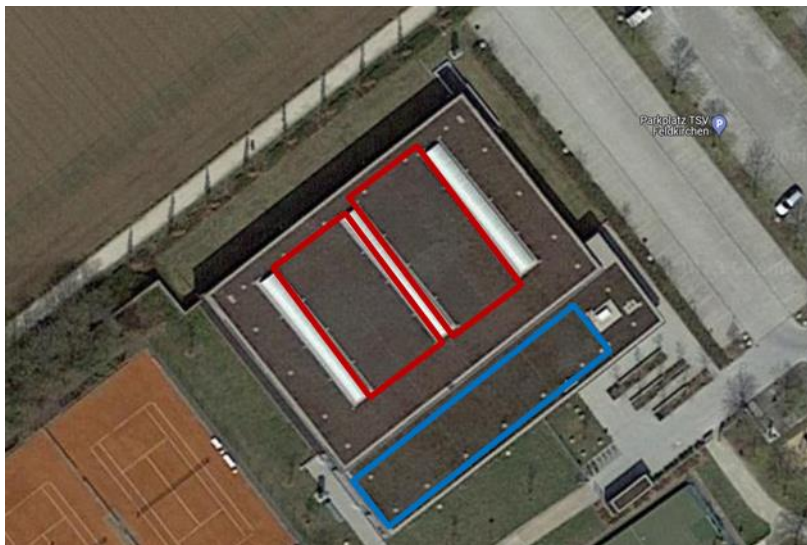
Abbildung 2: Dachflächen der Dreifachturnhalle
